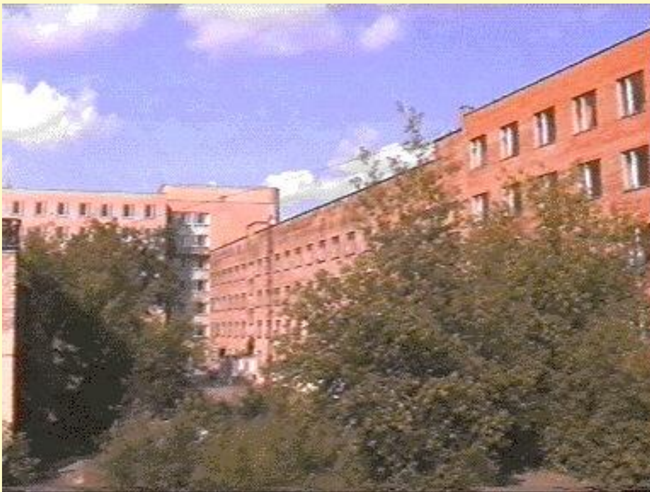
Комплекс зданий Отделения КРФ ФИАН, включающий четырёхэтажный корпус №1 ЛКРФ (в центре) и более поздние пристройки (семиэтажная слева и пятиэтажная справа)
